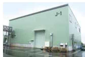
郡山工場の新純水棟
