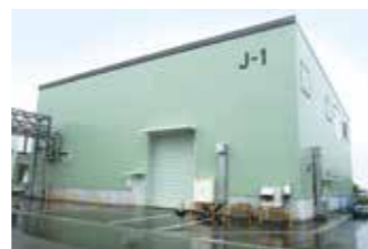
郡山工場の新純水棟
